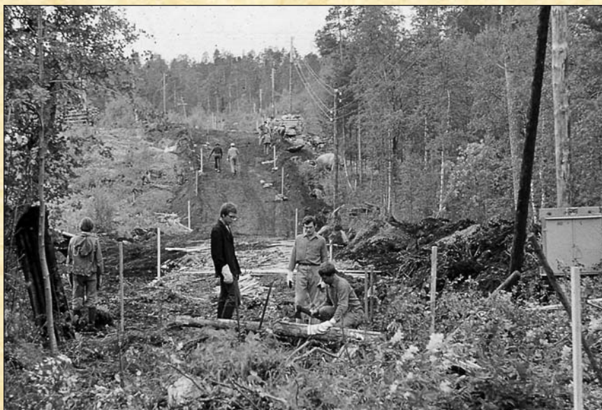
Начало работ по строительству собственной ЛЭП.
